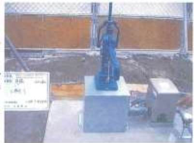
併用型井戸 (電動・手動型) 新宿再開発ビル 2008/9/10撮影 (東京都新宿区)
