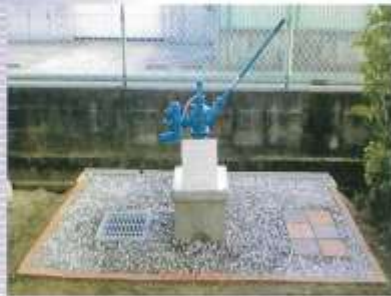
深井戸(手動型) 沖野小学校 2007/8/20撮影 (宮城県)
